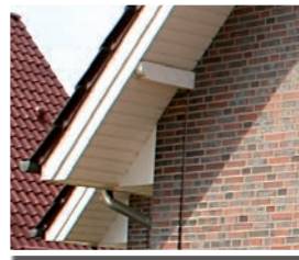
Giebelüberstände mit sichtbaren und profilierten Fuß- und Mittelpfettenköpfen
