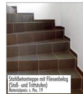
Stahlbetontreppe mit Fliesenbelag (Stoß- und Trittstufen) (Materialpreis: s. Pos. 19)
